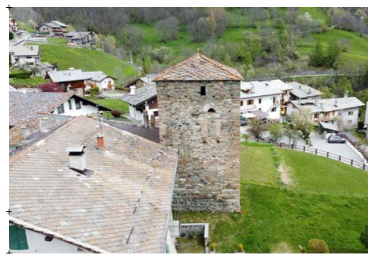
3// fotografia frontale della torre dove è possibile vedere l'ingresso
