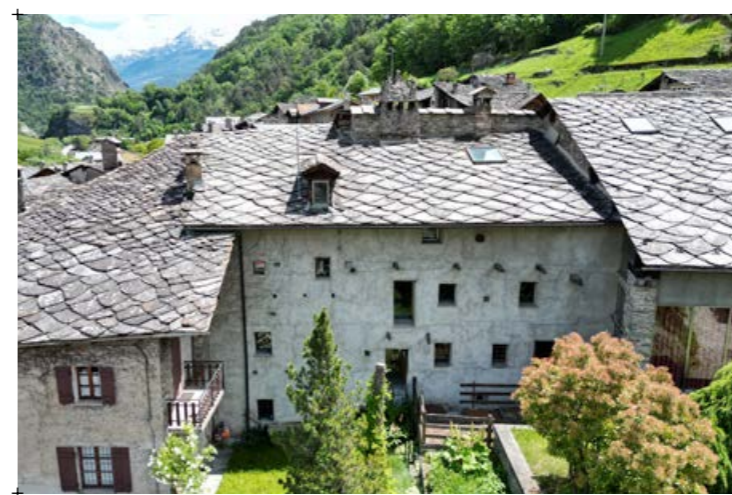
3// fotografia della facciata esterna, si evincono i caratteri della muratura portante in pietra date le piccole aperture
