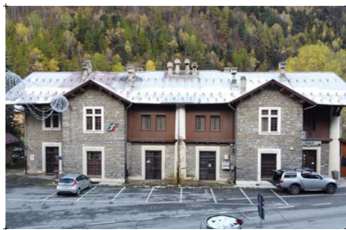
2// fotografia della stazione e binari; il degrado della ferrovia è evidente
