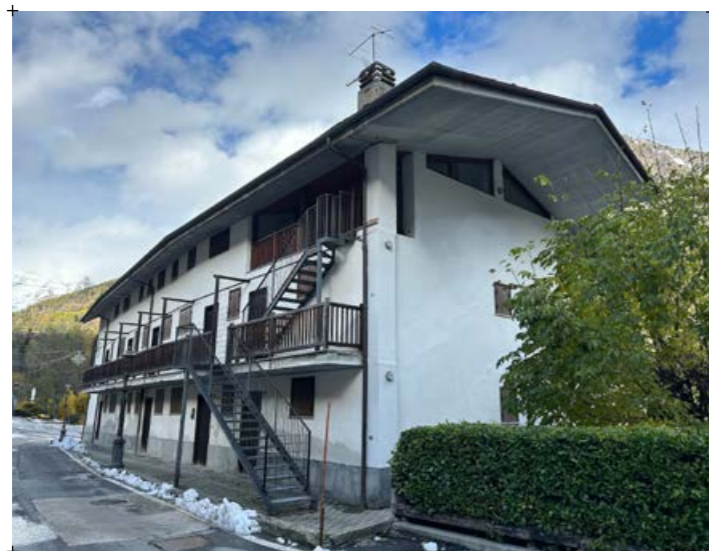
1// fotografia della testata posteriore dell'edificio. Si nota il forte aggetto della copertura in calcestruzzo armato
