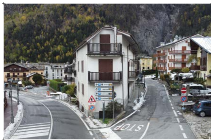
4// fotografia della testata dell'edificio in prossimità della biforcazione delle due vie che ne determinano la forma
