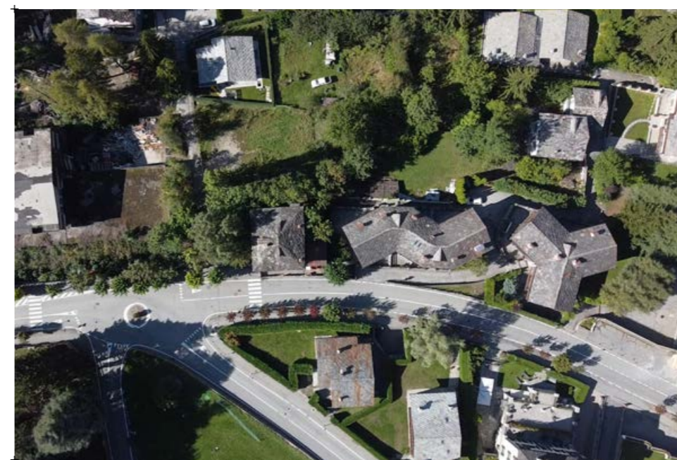
5// vista aerea dell'edificio nel contesto
